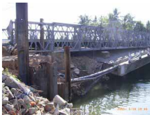
被災橋梁の応急復旧(スリランカ)
